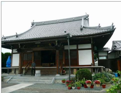
晴光院本堂。屋根瓦には菊花16弁の紋章。 現在の本堂は平成2年に新築された。
