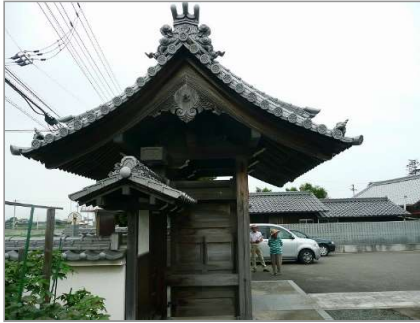
晴光院山門。かつては広大な寺領を持ち七堂 伽藍が完備し塔頭12寺を擁する大寺であった。
