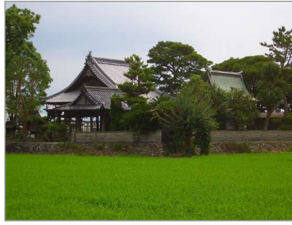
天神社北東からの全景
