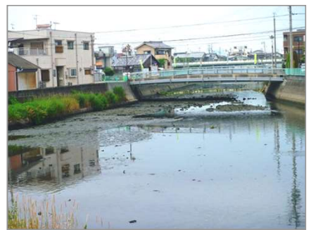
早舟川・土川が長尾谷川に合流点。 向うの橋は新立橋。
