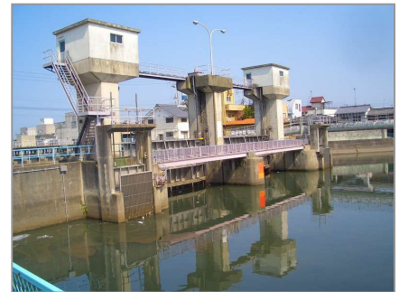
長尾谷川と海の境界の樋門。
