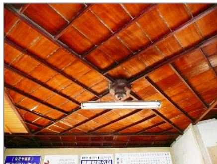
伊予鉄岡田駅舎の凝った天井。
