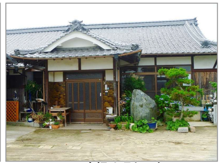
庫裡は昭和28年、子聖大権現堂は昭和35年に再建された。
