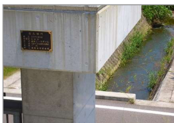
不用排水路・重信川へ流す樋門
