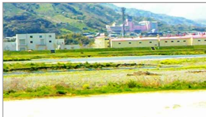
井門町側から伏樋暗渠で対岸の八倉へ引水
