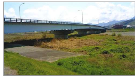
国道33号線重信大橋
