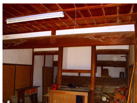
天長寺本堂内部
